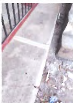
LOSA DE PATIO REPARACION DE LOSA DE PATIO DE PASILLO POR CAMBIO DE TUBERIA
