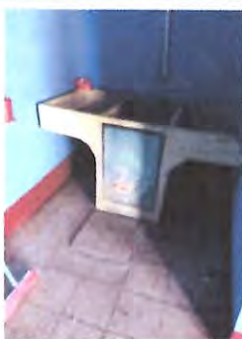
PILA, SUSTITUCION DE PILA Y TRABAJOS DE DRENAJES
