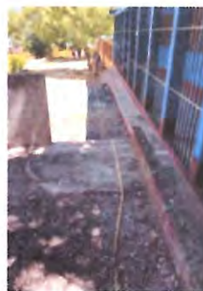
SUSTITUCION DE TUBERIA DE 4 PULGADAS A CANDELA MUNICIPAL DE DRENAJE
