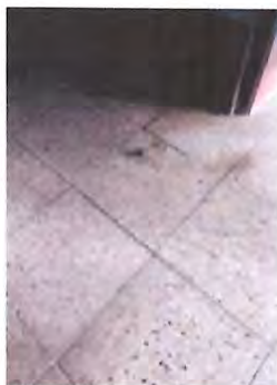
PISO, SUSTITUCION DE PISO POR TRABAJOS EN DRENAJES SERVICIOS SANITARIOS
