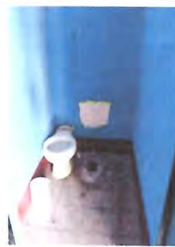
SERVICIOS SANITARIOS, SUSTITUCION DE SANITARIOS LAVABLES
